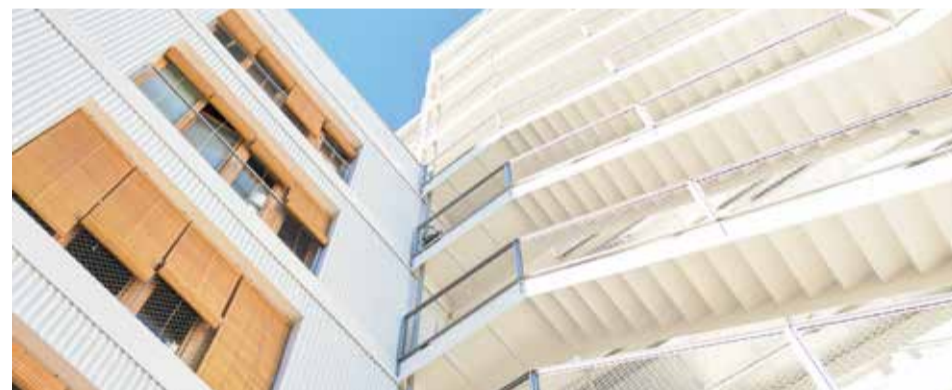
► Vistes exteriors de l'edifici cooperatiu, la Chalmeta.
